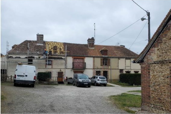
3 - Vue sur les maisons en bande, Ouest de la forge
